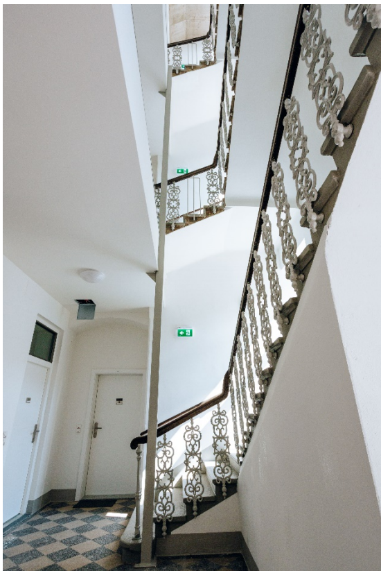
Die fein geschwungenen Treppengeländer bezeugen die Geschichte des Hauses.
