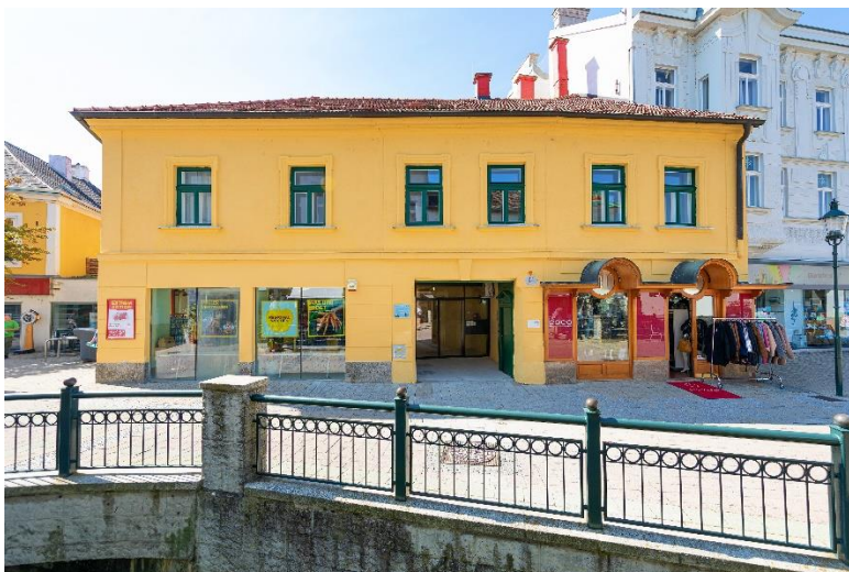
Stadthaus Am Mühlbach (Außenansicht)
